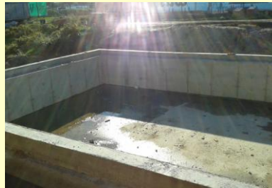
Das Bewegungsbad im Bau ...
