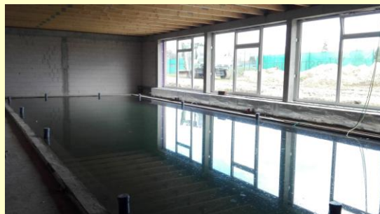
Die Baustelle im April 2016
